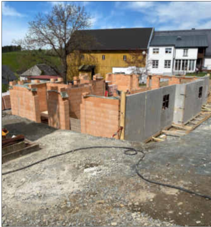
Die aktuelle Bauphase des Mehrfamilienwohnhauses.
