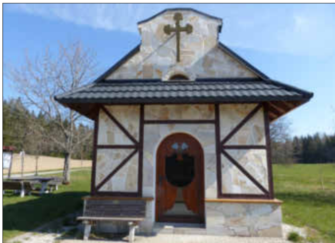
Die Flurkapelle in Hinterrehberg.
